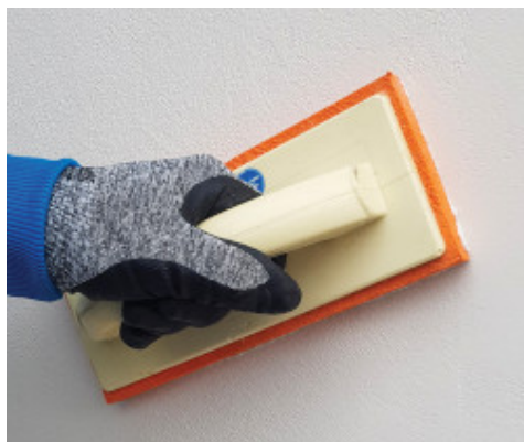
PoroMap Finitura Civile felületképzése szivacs simítóval
